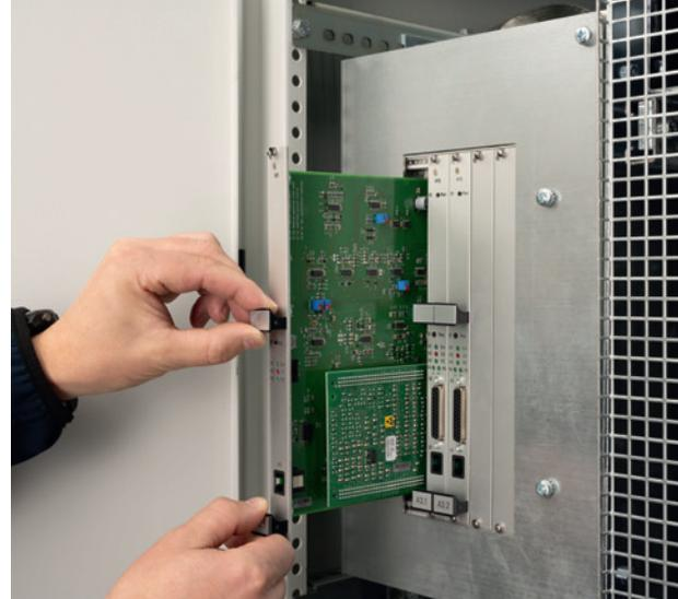
Die BSV/ZSV-Anlage ist mit diskreten Steuerungs- und Überwachungsbaugruppen (Einschubtechnik mit Frontsignalisierung) ausgestattet.
