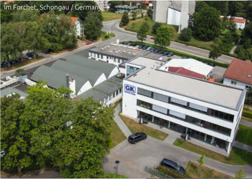
Greifenstraße, Schongau / Germany
