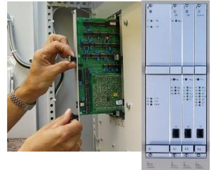
Die BSV/ZSV-Anlage wird mit diskreten Steuerungs- und Überwachungsbaugruppen (Einschubtechnik mit Frontsignalisierung) bestückt.
